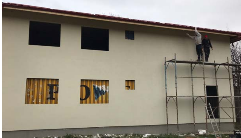
Dem Rohbau sieht man nicht an, dass er im Wesentlichen aus Schiffscontainern erstellt wurde.
